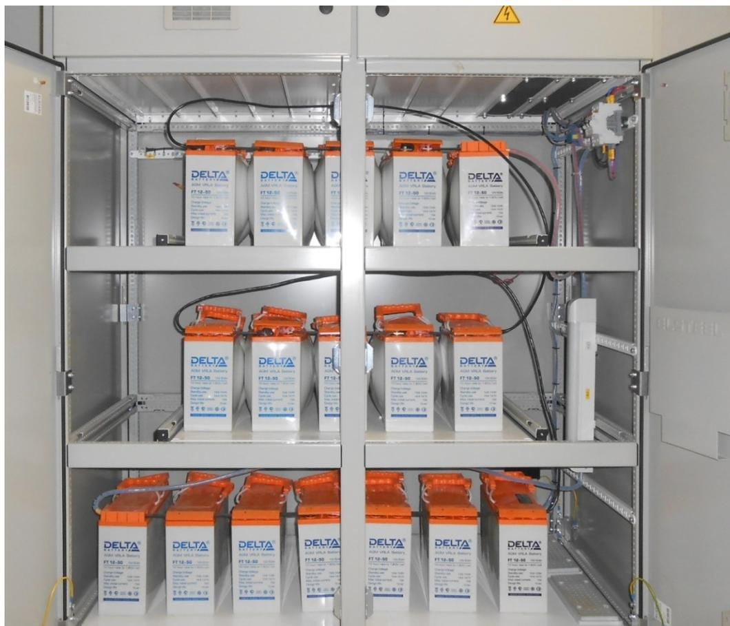
Рисунок 2. Аккумуляторный отсек ШОТ ЗРУ «КНС – А».
