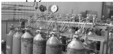
Рис. 1. Площадка с оборудованием для заправки баллонов
