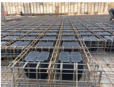
Рис. 1. Облегченное железобетонное перекрытие с U-BOOT пустотообразователями
