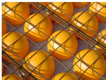
Рис. 2. Облегченное железобетонное перекрытие с пустотообразователями в виде части шаров
