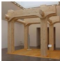
Рис. 3 Узловое соединение ригеля и колонны, используемое в здании TAMEDIA центра
