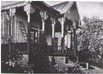
Рис. 2. Веранда на торцовом фасаде
