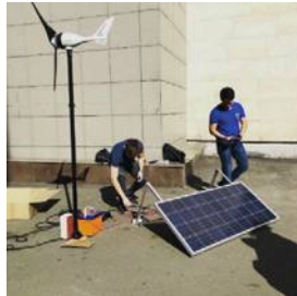
Рис. 2. Гибридная станция мощностью 650 Вт.
