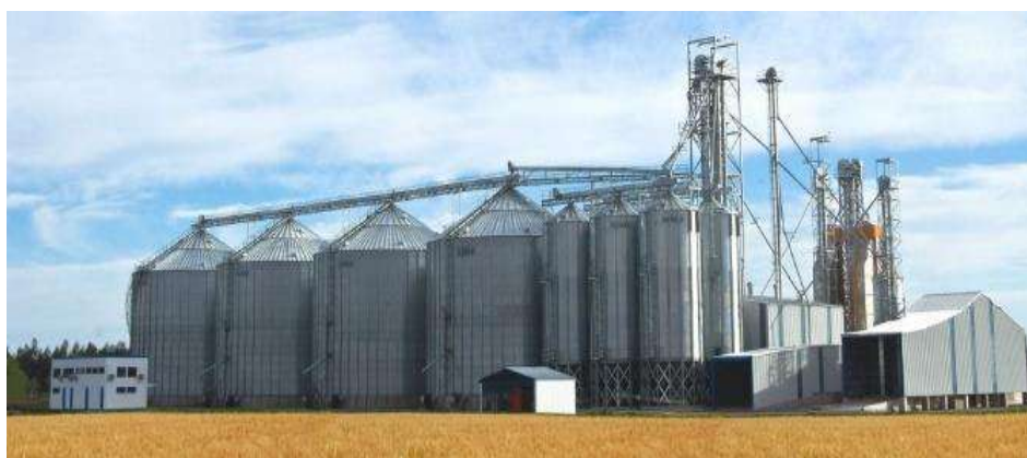
Рис. 1. Металлическое зернохранилище силосного типа
