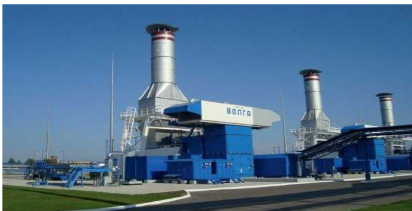
Рис.4. Газоперекачивающий агрегат ГПА-16 «Волга» с приводом от ГТДНК-16СТ
