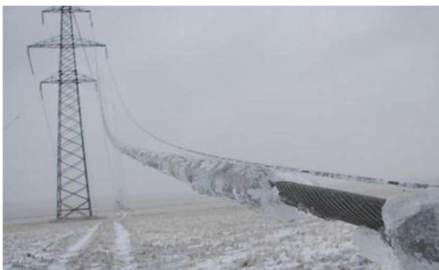
Рис. 1. Образование гололеда на ЛЭП
