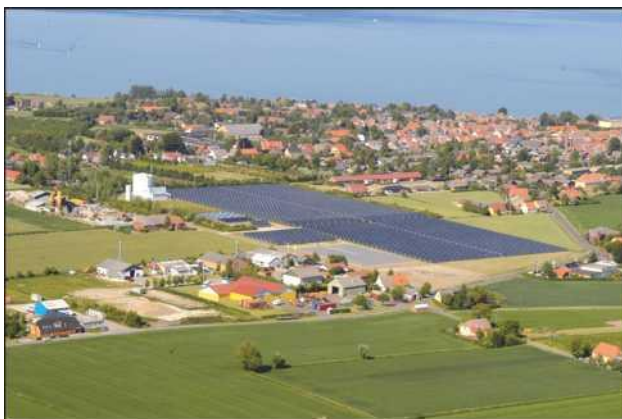
Рисунок 1 – Общий вид гелиоустановки тепловой мощностью 12,8 МВт (г. Марсталь, остров Аэро, Дания)
