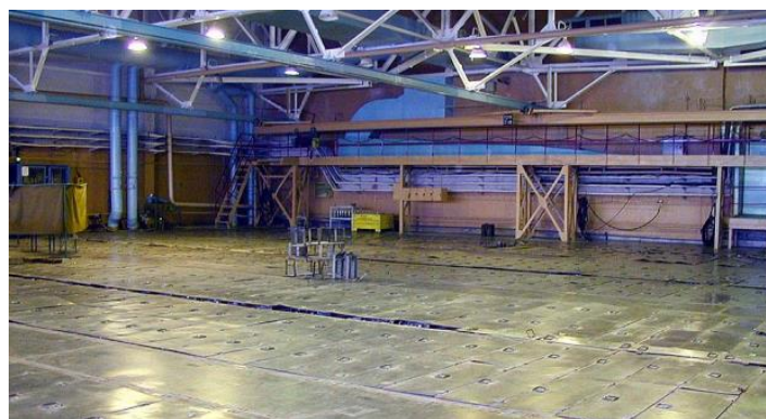
Рис.2. Хранение ОЯТ в бассейне выдержки отработавших тепловыделяющих сборок
