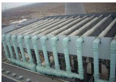
Рис. 3. Первый в мире крупный энергоблок 1000 МВт с системой непосредственного воздушного охлаждения – Линуйская ТЭС
