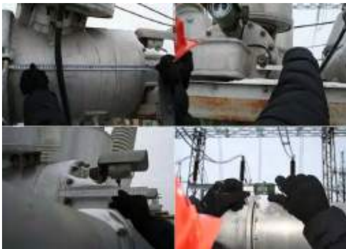
Рис. 3 – Пример процедуры снятия размеров и параметров внешних геометрических поверхностей выключателя ВЭБ-110
