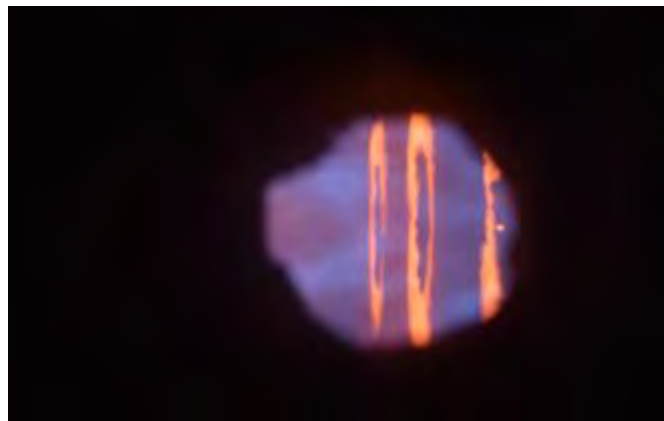
Рис. 7 – Стабильный режим горения на котле БКЗ-420-140
