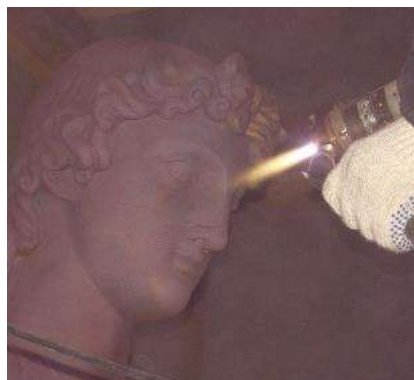
Рисунок 9 – Нанесение защитно-декоративного покрытия на скульптуру на здании Сената и Синода (Сенатская площадь, Санкт-Петербург)
