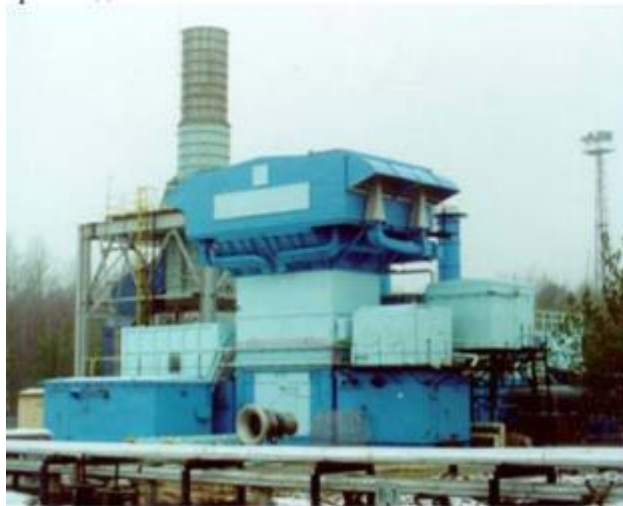
Рисунок 1.6. КВОУ для газоперекачивающего агрегата ГПА-16 «Нева». Первая ступень – прямоточные мультициклоны, вторая ступень – карманные фильтры.
