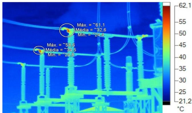
Рис. 1. Нагрев контактов на зажимах разъединителя
