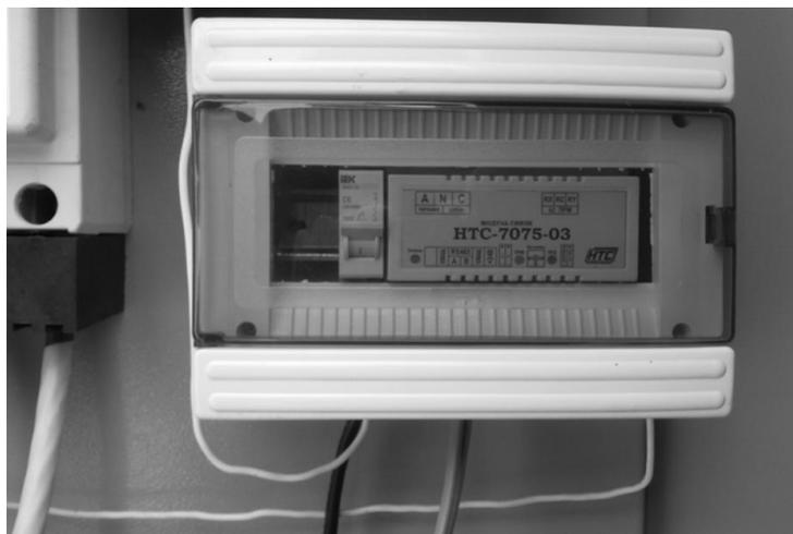
Рис. 1. Внешний вид модема PLC-10кВ
