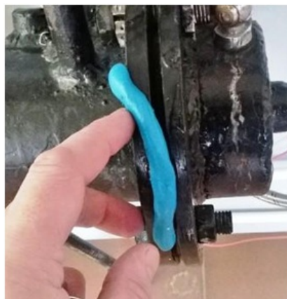
Рис. 2. Ремонт резиновой прокладки бойлера самовулканизуемым составом
